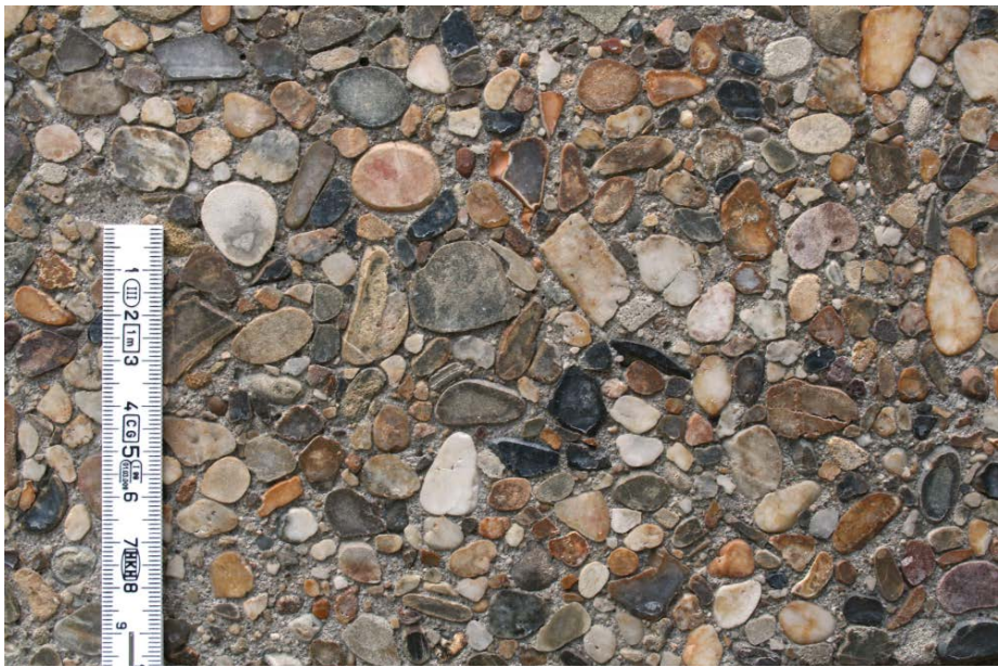
Afb. Detail van het betonoppervlak van de plint van de voormalige Twentsche Bank te Rotterdam. (Foto: Herdis Heinemann, 2010)
