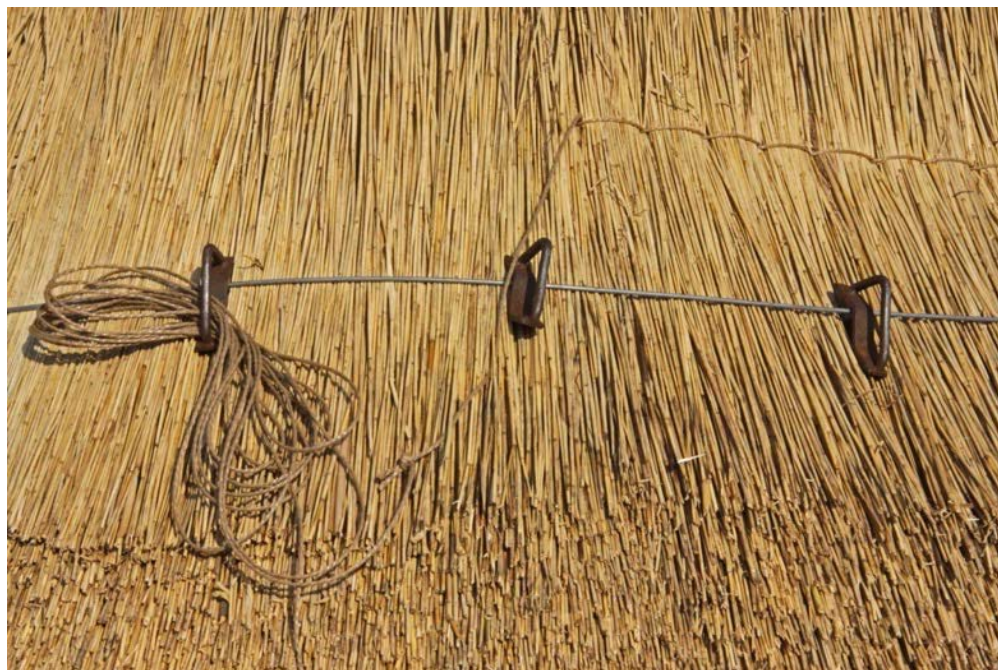
Figuur 18: Naaïen van riet op een veld van de molenromp. Onder: bij de 1e arbeidsgang wordt het riet voorlopig vastgezet met een gaarde van dubbel gegalvaniseerd draad. Rechtsboven: bij de 2e arbeidsgang wordt het riet met molentouw (linksonder) genaaid op de rietlatten.
