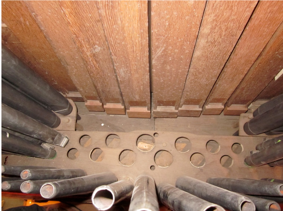
Bij dit orgel zijn in het verleden enkele pijpen uitgenomen. De houten pijpen vertonen sporen van schimmel, bij de metalen pijpen is stemschade te zien aan de bovenranden.
