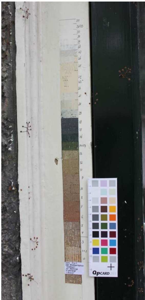
Fig. 4. Voorbeelden van een kleurentrap of stratigrafie. Links op een kozijnstijl van het Duivenhuis in Artis te Amsterdam, rechts op een raam van de Hildegardis meisjesschool te Rotterdam.
