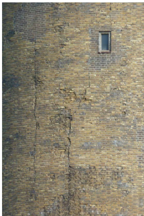
Afbeelding 5: Transversaalscheuren
