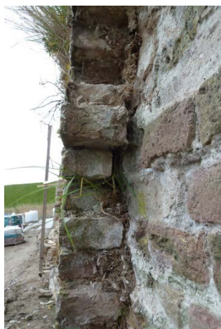
Afbeelding 3: Lateraalscheur
