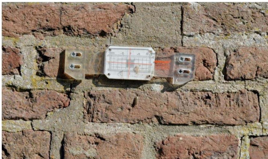
Waterpassing voor monitoring ongelijkmatige zetting – rotatie
