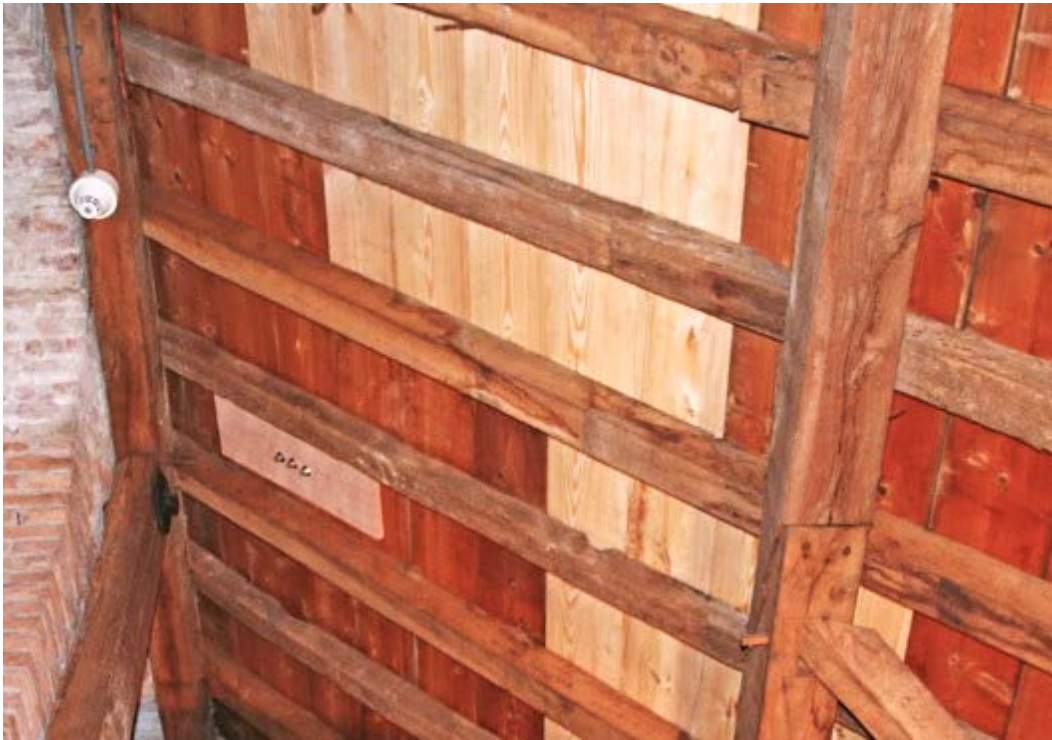
Kopiëren - partieel herstel van dakbeschoot in dezelfde houtsoort en in dezelfde breedte als bestaand.
