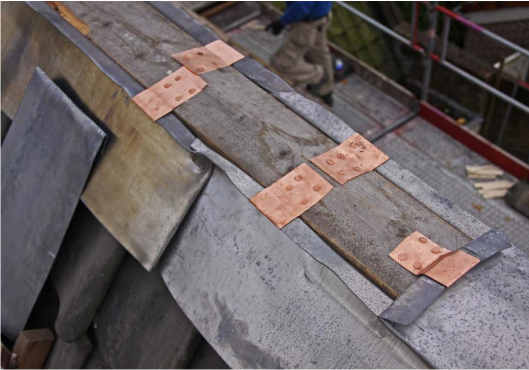
Figuur 8: Nokllood aangebracht in 3 delen van 25 kg/m 2 , vastgezet met koperen klangen. De delen zijn in lengtes van 1,0 meter verschervend aan elkaar gefelst.
