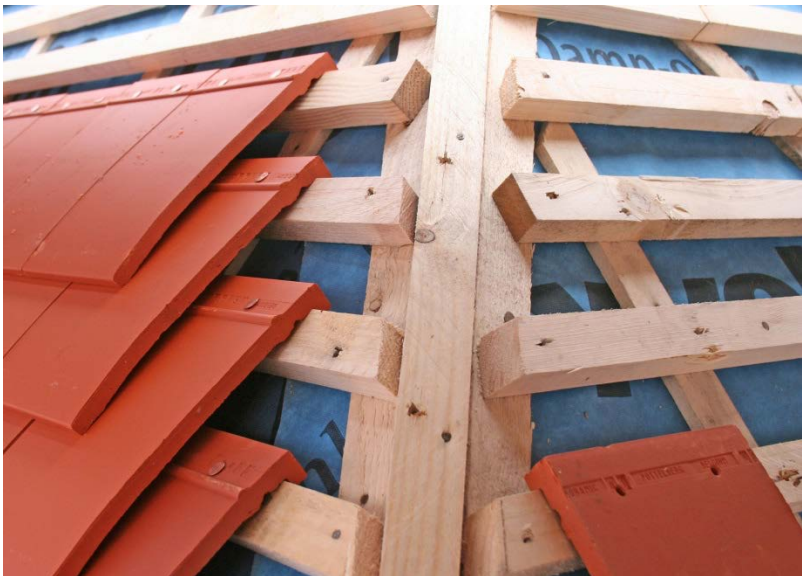
Figuur 11: Vernieuwen in de categorie 3B Imiteren met nieuwe leipannen. De leipannen worden op latten aangebracht. De juiste overlap plus latafstand staat in de ontwerp- en uitvoeringsrichtlijnen voor dakbedekkingsconstructies met keramische en betonnen leipannen PBL 24-103: 2011.
