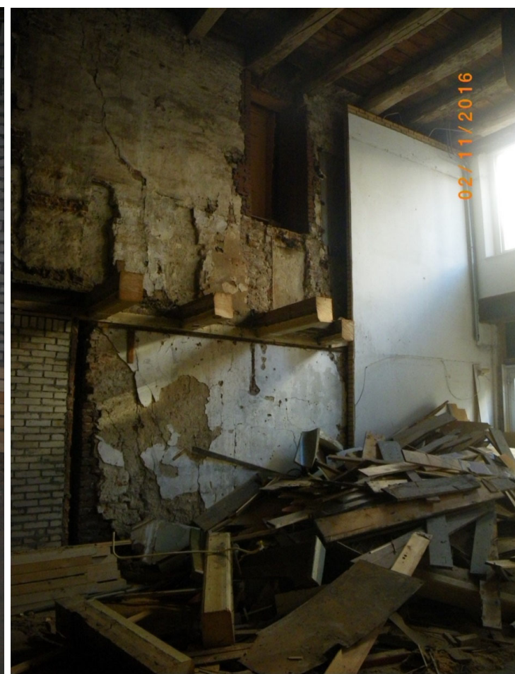
De volledig gesloopte ambachtelijke trap op één hoop
