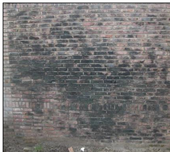
Schimmels door behandelen met suikerwater (2.3.a)
