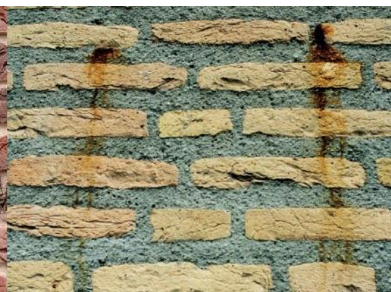
Roestende pyrietpitten in voegwerk (2.5.b)
