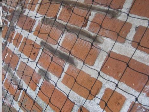
Verkleuring door weekmakers uit vogelweringskit (2.3.b)
