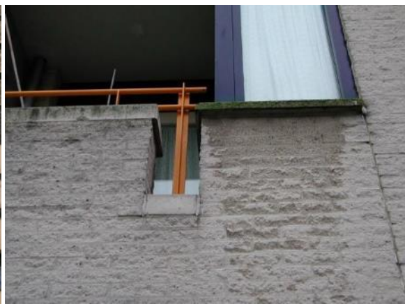
Atmosferisch vuil op gehydrofobeerde kalkzandsteen onder een raam (2.3.b)
