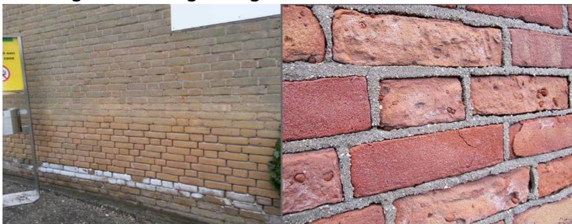
Witte uitbloei en schade aan voegwerk door doozout (2.1.a)
