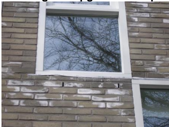
Uitbloeï van oplosbare zouten (2.1.b)
