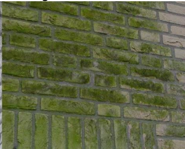
Alggroei door ondeskundig reinigen met een middel op basis van fosfor- of zoutzuur (2.4.a)
