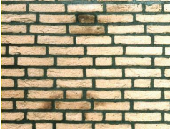
Bruine verkleuring door formaldehyde uit minerale wol (isolatie) (2.3.b)
