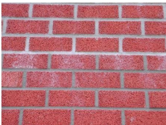
Kleurverschil in voegwerk door uitbloeï van kalk uit de voegmortel (2.1.b)
