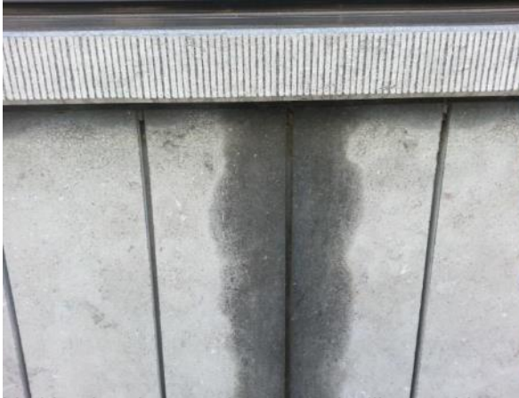
Verkleuring door weekmakers uit siliconen kit bij hardsteen (2.3.b)
