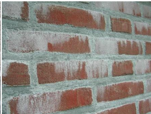
Uitspoelen van kalk uit vers voegwerk (2.1.b)
