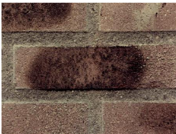
Mangaanroest op een strengperssteen (2.5.c)
