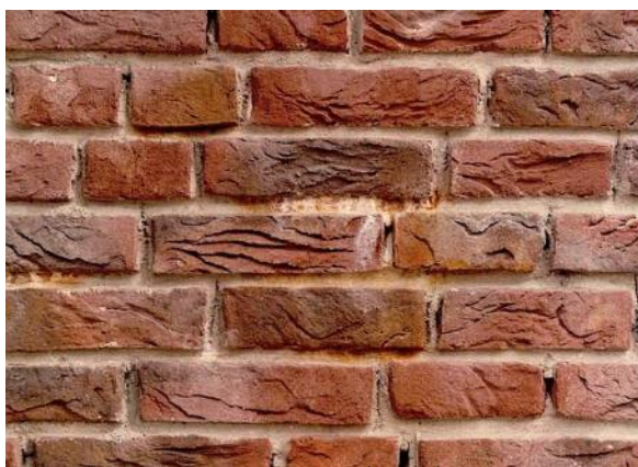
Roest van pyriet op stenen (2.5.b)
