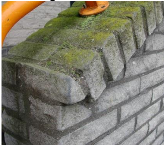
Algen en mossen op een rollaag (2.4.a)
