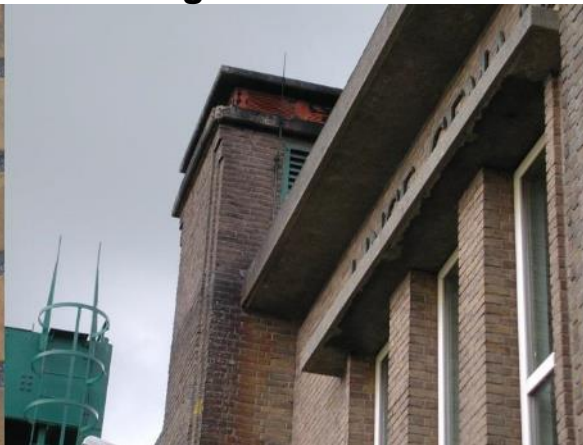
Vervuiling door roet (2.3.b)
