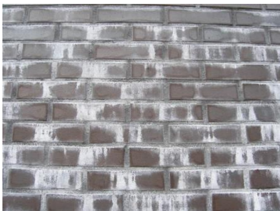
Witte afzettingen door uitloging van de metselmortel (2.1.b)
