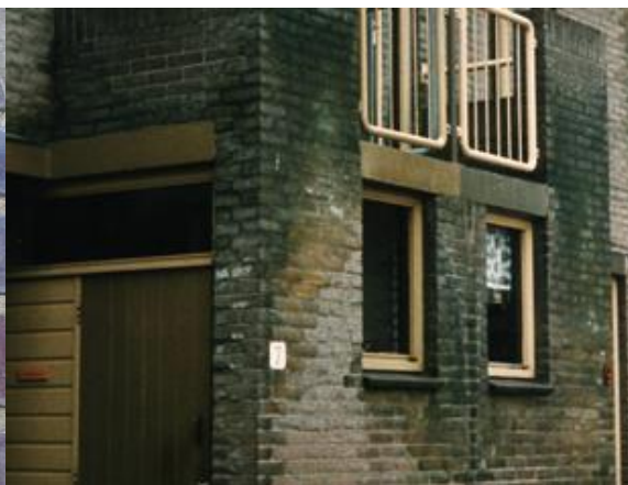
Vanadiumuitbloei in verschillende kleuren (2.4.b, 2.5.c)
