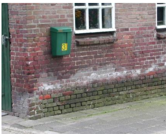
Uitbloei van nitraat op een stal (2.1.a)
